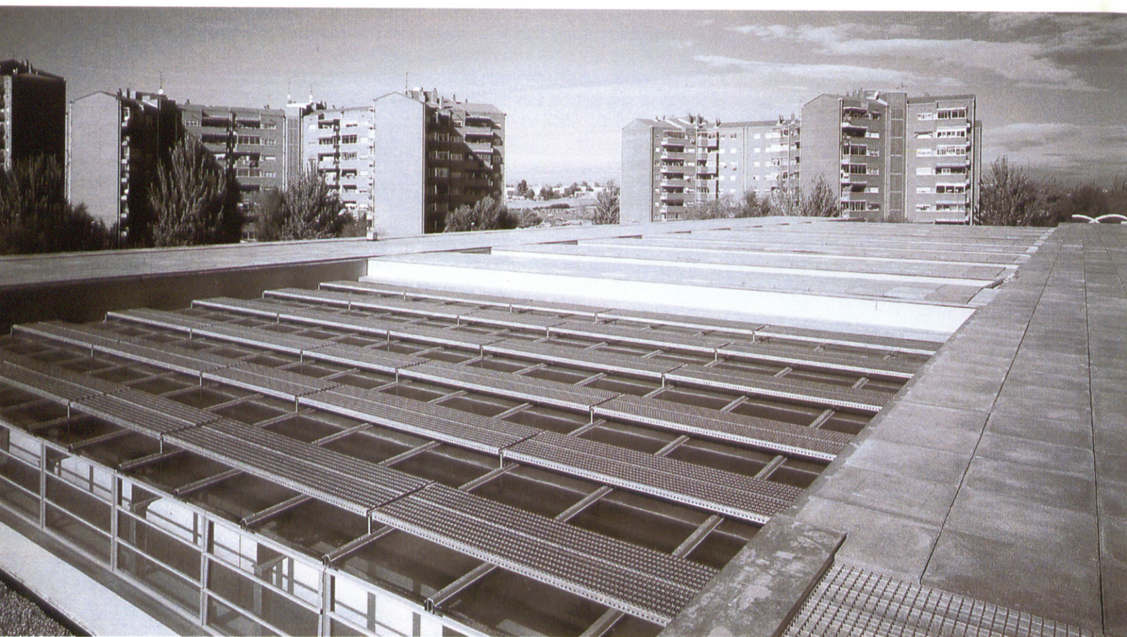
43 · DETALLE DE LA CUBIERTA
